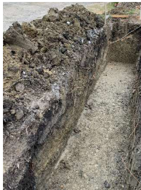
Fig. 11. Nivelación de suelo de cimentación para construcción de muro
