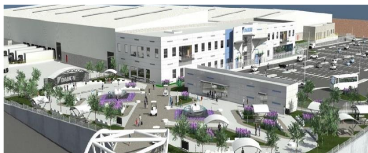
Figura 1.- Planta de Chillers en SLP
